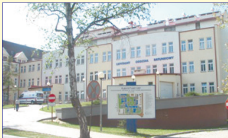
Nowy blok Powiatowego Szpitala w Iławie
