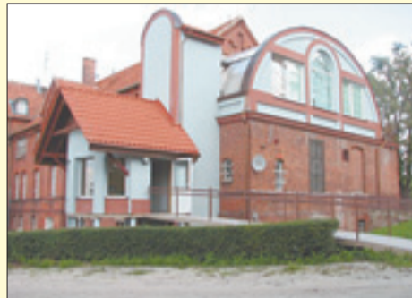
Przebudowa część Domu Pomocy Społecznej w Suszu
